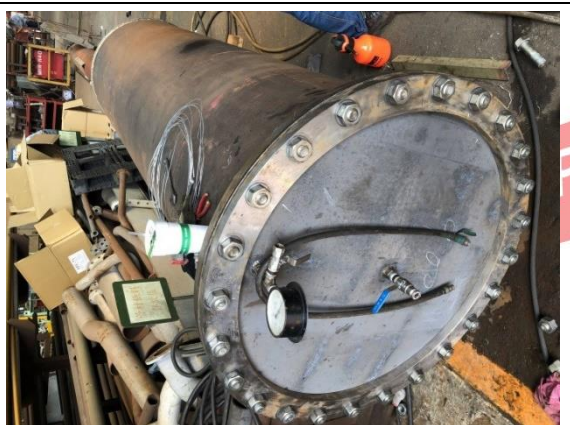
海底門至機艙 700A 排外貫穿管安裝作業
